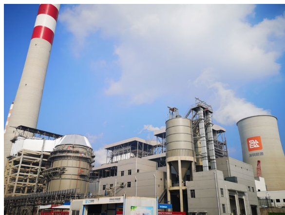
菲达环保承建的河源电力 2×1000MW 机组脱硫 EPC 项目
