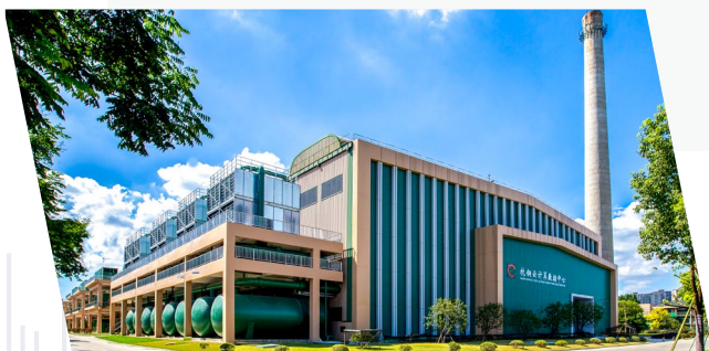
杭钢云计算数据中心外景
