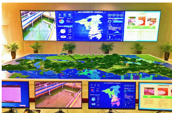
富春紫光环保打造的象山县域城乡污水一体化处理平台
