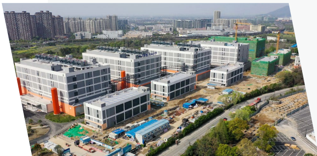
浙江云计算数据中心（北区）现场施工图
